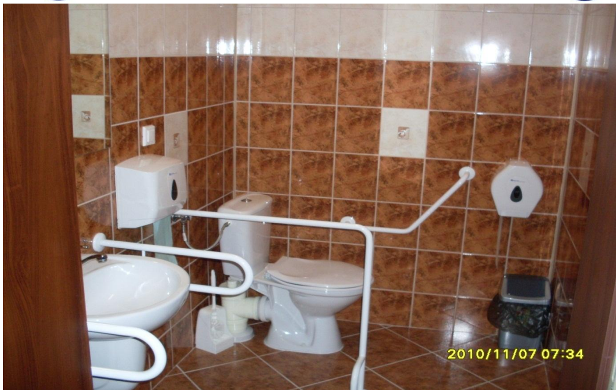
Fot.4. - Sanitariat dla niepełnosprawnych Gimnazjum w Okonku
