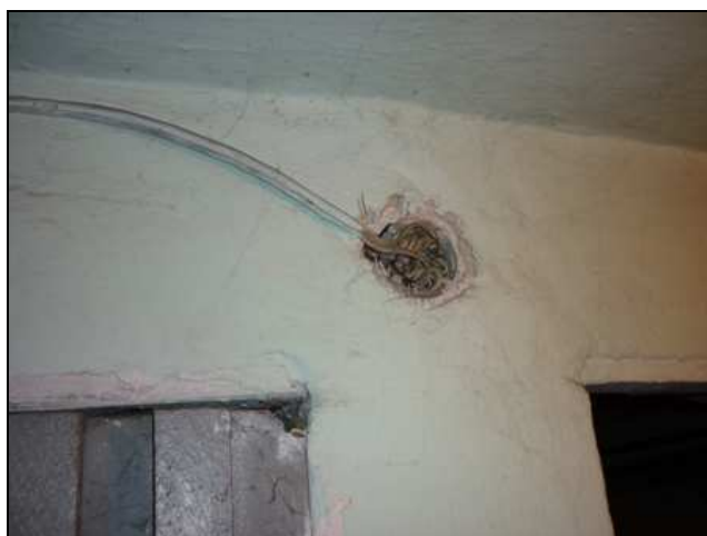
Nieprawidłowy montaż instalacji elektrycznej, oświetleniowej (obiekt kościelny)
