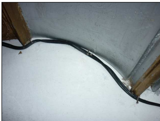
Nieprawidłowy montaż instalacji elektrycznej, oświetleniowej (obiekt kościelny)
